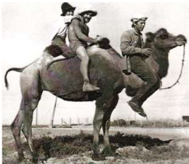
Строительные отряды на полуострове Мангышлак
