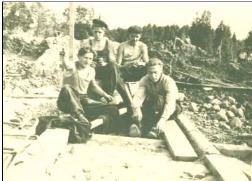
Рис. 1. Студенты–строители ЛТИ на Дороховской ГЭС
